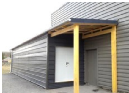
Zone de décontamination
